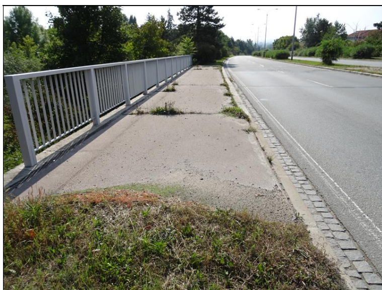
15.JPG Levý chodník a zábradlí v pohledu po směru staničení převáděné komunikace - příčné trhliny v povrchu chodníku, ve spárách uchycená vegetací.
