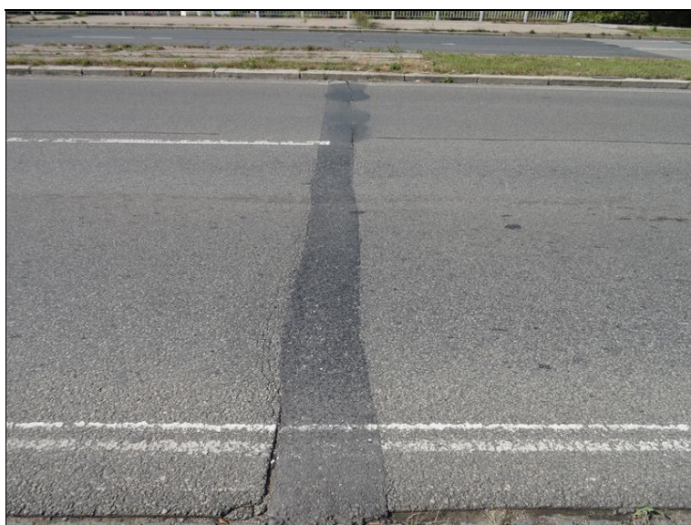
12.JPG EMZ ve vozovce nad Op1. Lokál. trhliny mezi tělem EMZ a krytem vozovky.
