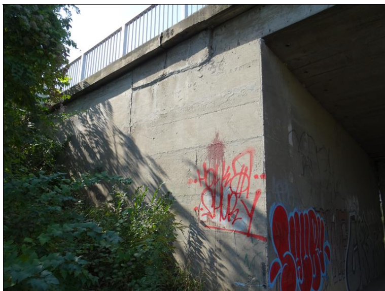
8.JPG Levé křídlo Op2. Pod dilatační spárou římsy svislá trhлина v křídelním boku závěrné zídky.
