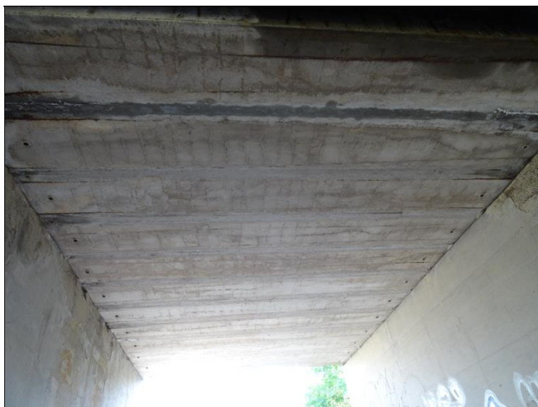
11.JPG Podhled NK směrem k levé straně mostu. Průsaky vody - nejvíce v oblasti pravého krajního nosníku.
