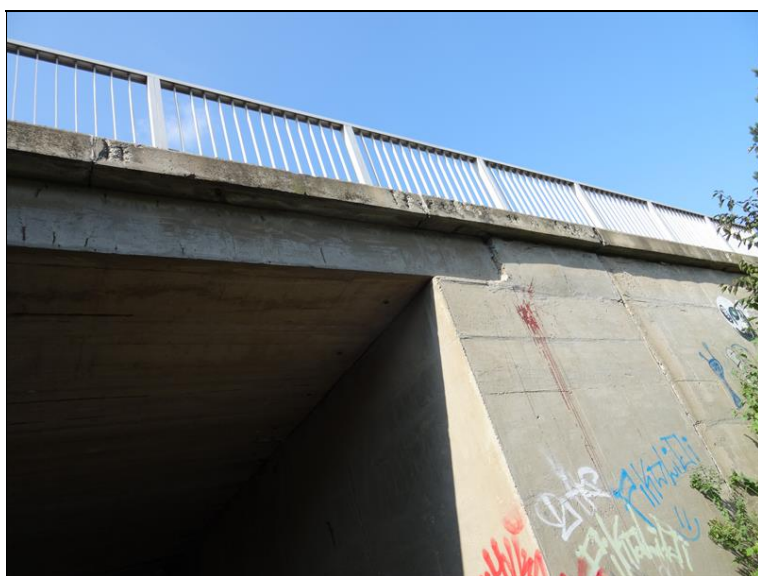
18.JPG Lokální odpady krycí vrstvy výztuže čele levé římsy, Obnažená výztuž koroduje,
