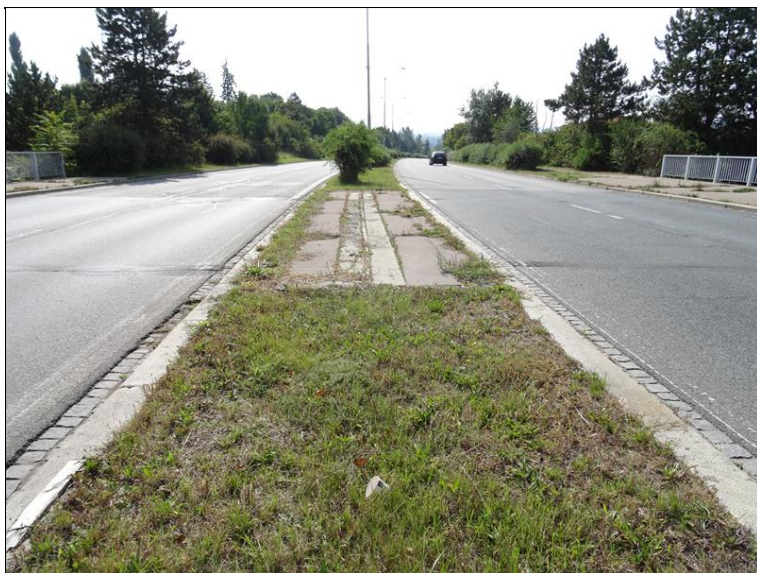
2.JPG Pravá střední římsa, vegetace ve spárách.
