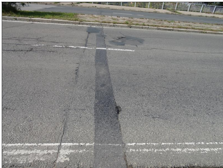
13.JPG Vozovka v místě EMZ nad Op2. V krytu vozovky výtluky a trhliny.
