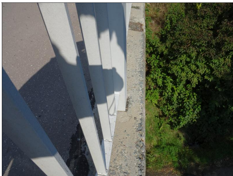
16.JPG Degradace betonu na horním povrchu levé římsy.
