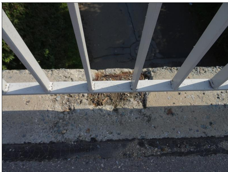
17.JPG Detail degradace betonu římsy, koroze obnaženého ocel. prvku zabeton. do římsy.
