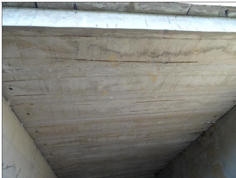
10.JPG Podhled nosné konstrukce (NK) zleva. Prokopírovaná korodující výztuž. Krajní nosník - lokálně odhalené korodující třmínky, průsaky pod římsou.
